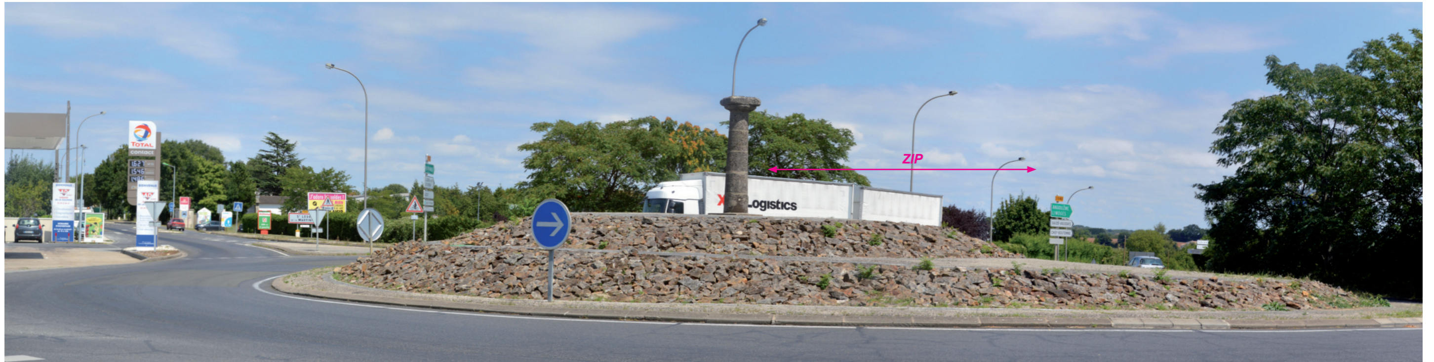
Photographie 29 : Perception limitée de la ZIP depuis l'est de Melle
